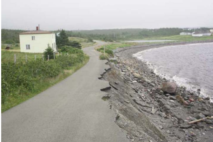
Figure 32. Érosion côtière à Admiral's Beach, à la presqu'île Avalon, érodant cette voie de transport. Source : Batterson et Liverman, 2010 180
